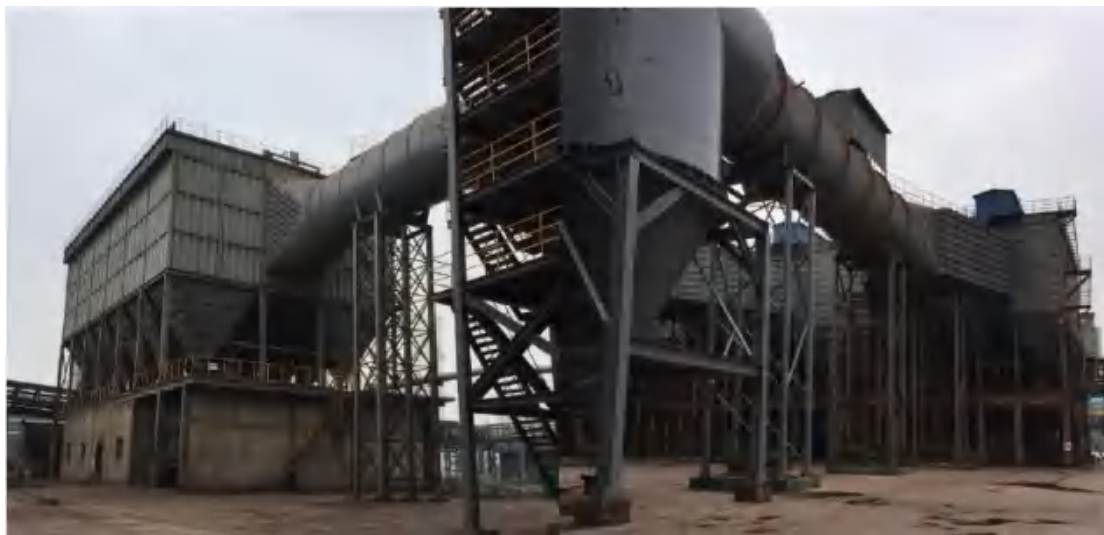
图 8.1-3 低压脉冲布袋除尘器
