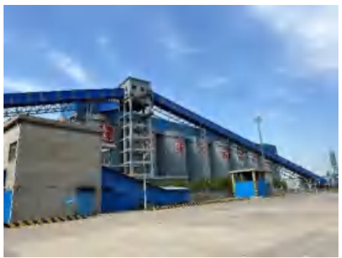
废水处理、原料筒仓、封闭输送带 现有项目部分实景图
